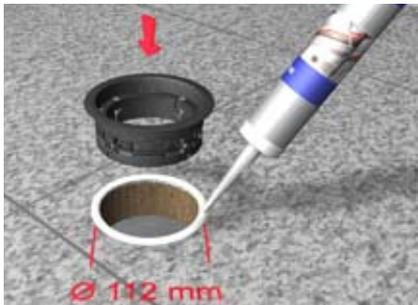
Leitungsauslass LATU G20 wird von oben in die Einbauöffnung eingesetzt und mit geeignetem Dichtmaterial eingeklebt. Die Einbauöffnung hat einen Durchmesser von 112 mm.
