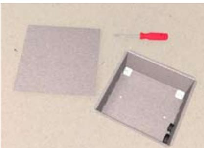
Schutzdeckel entfernen nachdem Estrich vollständig ausgehärtet ist.
