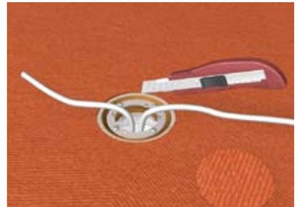
Nach Verlegung des Bodenbelages Bohrlocher mit einem Cuttermesser freischneiden.
