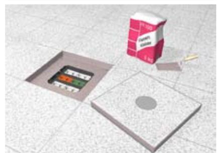
Kassettendeckel mit Bodenbelag belegen. Darauf achten, dass der Kleber gleichmässig verteilt wird und der Belag plan im Kassettendeckel aufliegt, ansonsten besteht Bruchgefahr des Belages.
