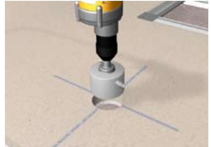
Unterflurkanal mit Sägekranzaufnahme aufsägen.
