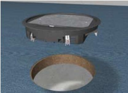
Versorgungseinheit in die Einbauöffnung einsetzen.
