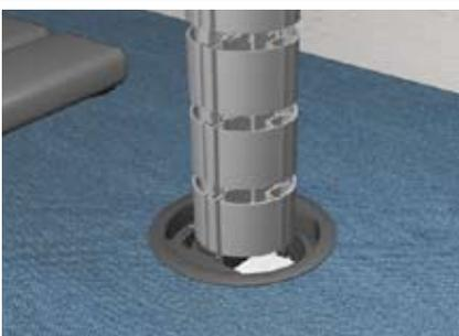
Nach gleichem Prinzip des Anschlussadapters wird die Rundkette an den Leitungsauslass angeschlossen. Einstecken und anschließend von der Seite in mittige Position schieben.
