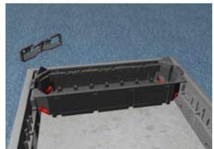
Gerätebecher horizontal in der Versorgungseinheit ansetzen. Die Ecken des Gerätebechers sind umgeklappt.
