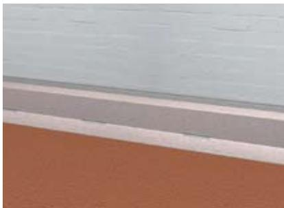
Bodenbelag bis an die Kanalunterteile des montierten Systems heran verlegen.
