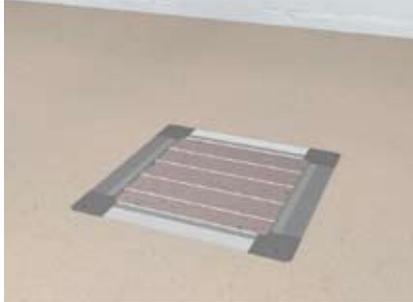
Estrich wird bis zur Oberkante der Zug- und Abzweigdose verlegt. Der Montageschutzdeckel dient nur als Schutz vor Verunreinigung und darf nicht überfahren oder belastet werden.
