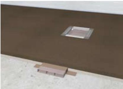
Beim Heißeestrich/Gussasphalt werden Temperaturen von ca. 280 Grad Celsius erreicht. Aus diesem Grund müssen die Kanäle und Zug- und Abzweigdosen mit bitumierter Wellpappe abgedeckt und isoliert werden. Die Kabelverlegung darf wegen den hohen Temperaturen erst nach vollständigem Auskühlen des Heißeestrichs erfolgen.
