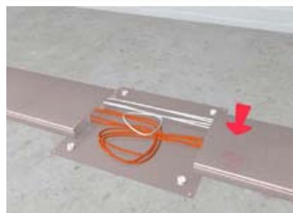
Deckel vom Unterflurkanal werden von oben aufgelegt und eingerastet.
