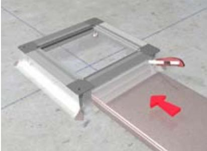
Folien-Estrichschalung in Höhe und Breite des Kanals einschneiden. Folienlasche anheben und Kanal bis zum Anschlag auf dem Bodenblech oder ca. 40 mm unter die Zug- und Abzweigdose einschieben.
