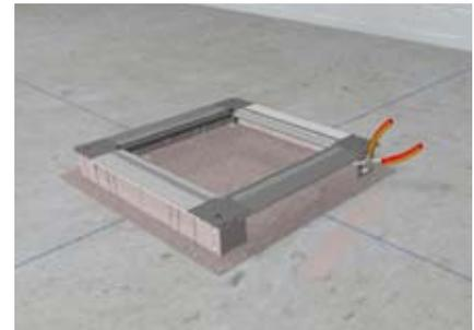
Um den Unterflurkanal an die Zug- und Abzweigdose anzubinden, muss vorher das entsprechende Seitenteil ausgeklinkt werden. Dazu mit einem Seitenschneider entlang der passenden Perforation das Blech aufschneiden.
