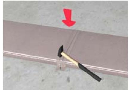
Am Stoß zwei Kanalstücke mit einer Schelle verbinden und über zwei Befestigungslöcher (7 x 15 mm) auf Rohdecke andübeln. Die Montage der Schelle ist auch erforderlich, um zwischen den Kanälen den Potentialausgleich nach DIN VDE 0100 zu gewährleisten.
