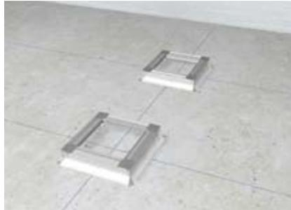
Zug- und Abzweigdosen gemäß Verlegeplan auf der Rohdecke aufstellen. Die Folien-Estrichschalung muss außen liegen.
